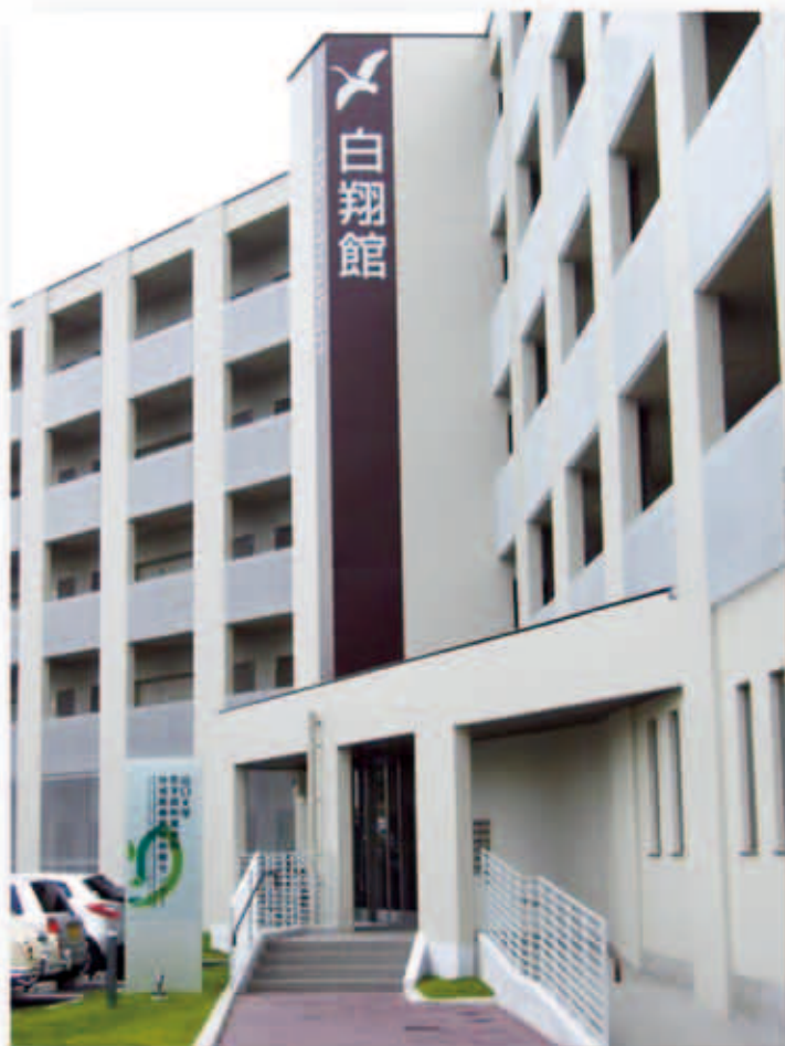
山口大学医学部附属病院に隣接する臨床研修医向け宿舎
